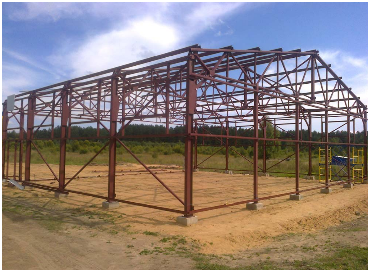
Строительство авиационного ангара размерами 16х14х4,2 (224 м2) из профилированного листа. Место строительства Тверская область, деревня Судниково .
